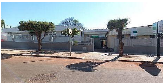
Conclusão da revitalização do Hemocentro de Ceres
